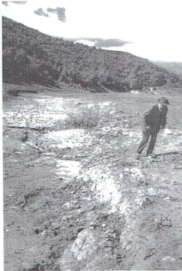
La source sulfureuse, rive gauche, dans l'ancien lit de la Laye. Au dessus du Père Conte le pont qui traverse la Laye en amont du barrage.
